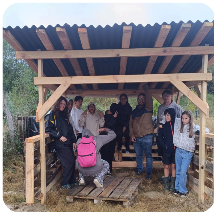
Construire un abri pouvant servir à la récupération de l'eau avec l'aide des Compagnons Bâtisseurs
